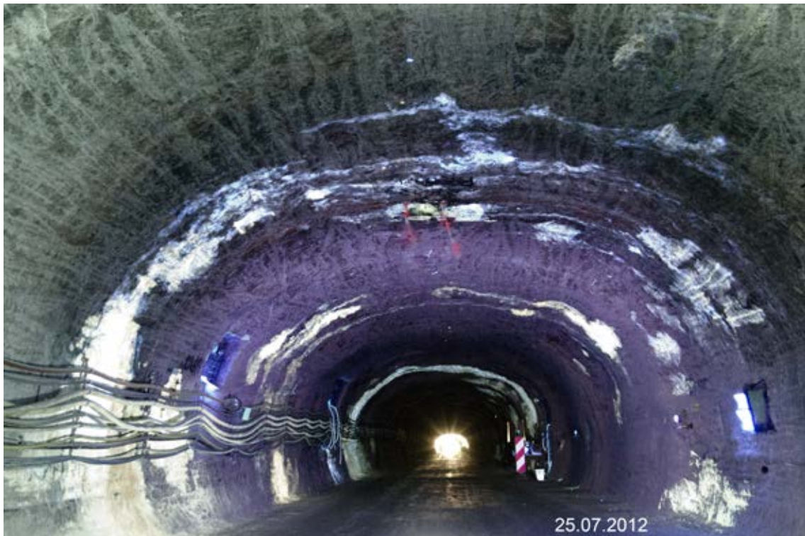
Abb. 8: UV-Aufnahme im Q1W (Blickrichtung von SSE). Die KW erscheinen im Q1W als gelblichweiße Kondensatfahnen, die sich, ausgehend von einigen, wenige cm-breiten, bläulichweißen Schlieren (vgl. Abb. 5, 7 und 9) infolge von Beraubearbeiten und daran gebundenen Verschmierungen sowie durch die Schwerkraft großflächig am Stoß und an der Firste verteilen. Die KW-Belastung im Q1W erscheint in Folge dessen deutlich größer und suggeriert ein scheinbar großflächiges KW-Vorkommen (Aufnahme DBE).
